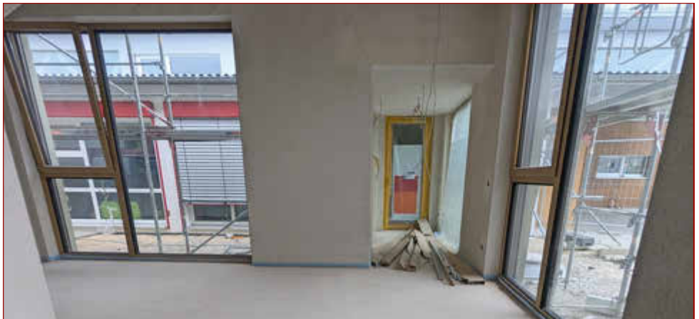
Blick vom Neubau zur Krippe, rechts der Verbindungsgang mit Tür zur Krippe im Rohbau.
